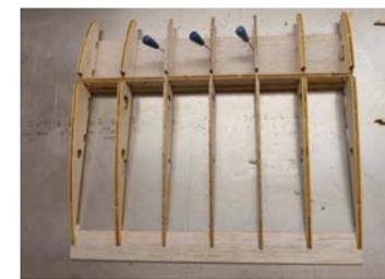
Für den Aufbau der vier Tragflächenhälften wird eine gerade, verzugsfreie Unterlage benötigt, um einen Verzug zu vermeiden. Auch hier findet keine Planunterlage Verwendung, da sich die Anordnung der Rippen aufgrund der durchdachten Konstruktionsweise von selbst ergibt.
