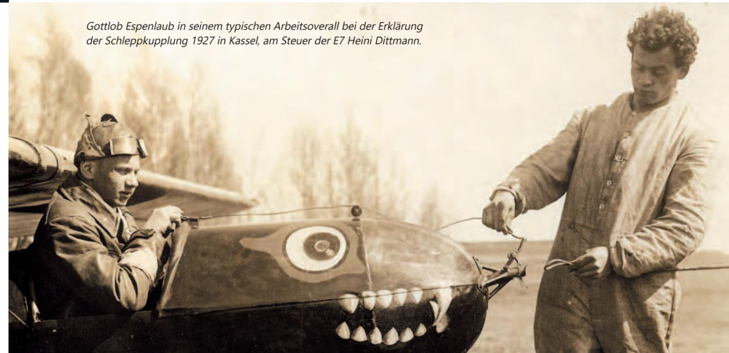
Gottlob Espenlaub in seinem typischen Arbeitsoverall bei der Erklärung der Schleppkupplung 1927 in Kassel, am Steuer der E7 Heini Dittmann.
