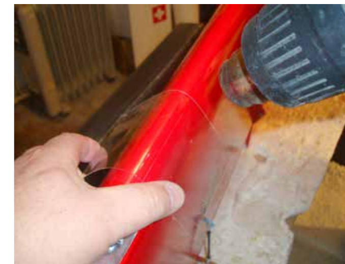
Anpassung der Kunststoff-Folie, die als Verglasung dient
